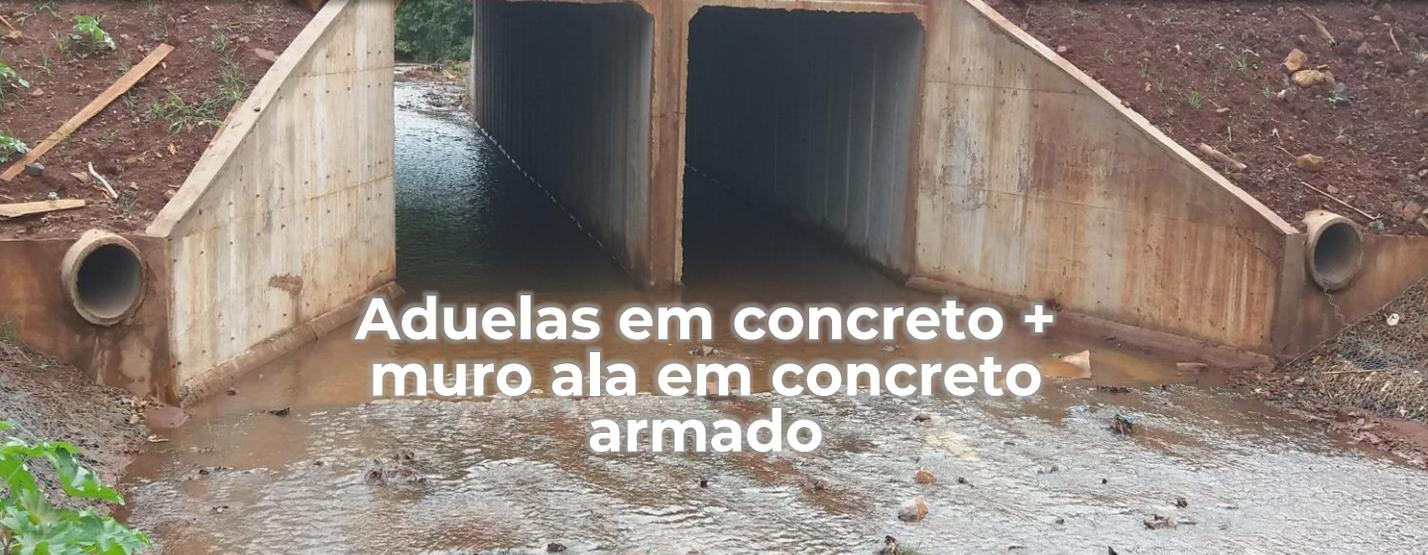
**Aduelas em concreto + muro ala em concreto armado**
